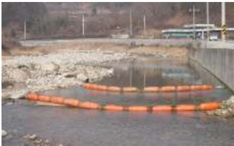
오탁방지막 설치(예시)
