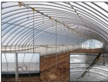
<보강지주 설치 전경>
