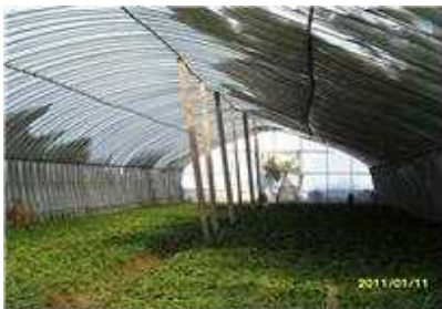
<보조 버팀기둥 설치>
