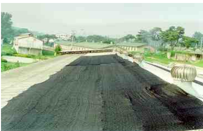
<그림 3> 축사지붕 및 축사내에 차광망을 설치한 장면
