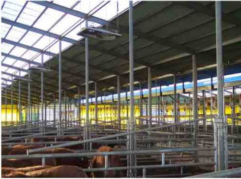
<그림 11> 사각 송풍팬 설치
