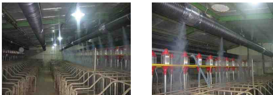
<그림 9> 돈사내부 환기를 위한 덕트 설치
