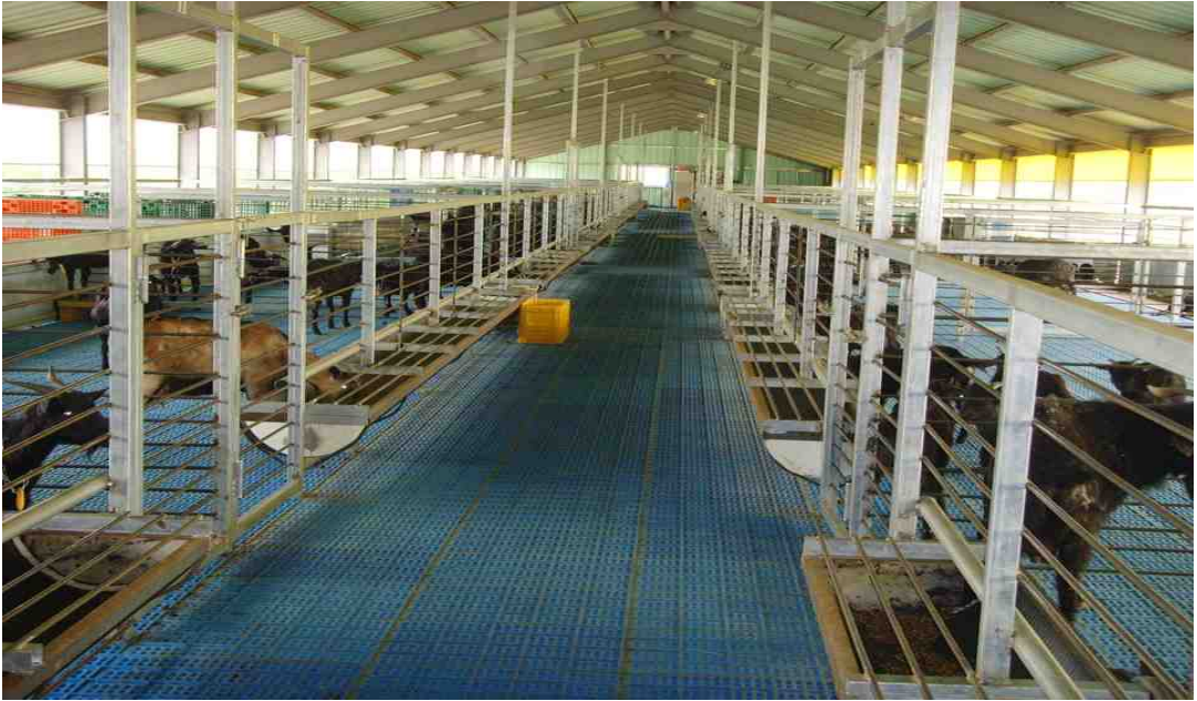
<환기시설이 잘된 염소 축사>
