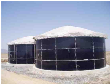
액비저장조 (지붕 설치)
