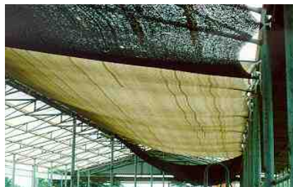
<그림 3> 축사지붕 및 축사내에 차광망을 설치한 장면
