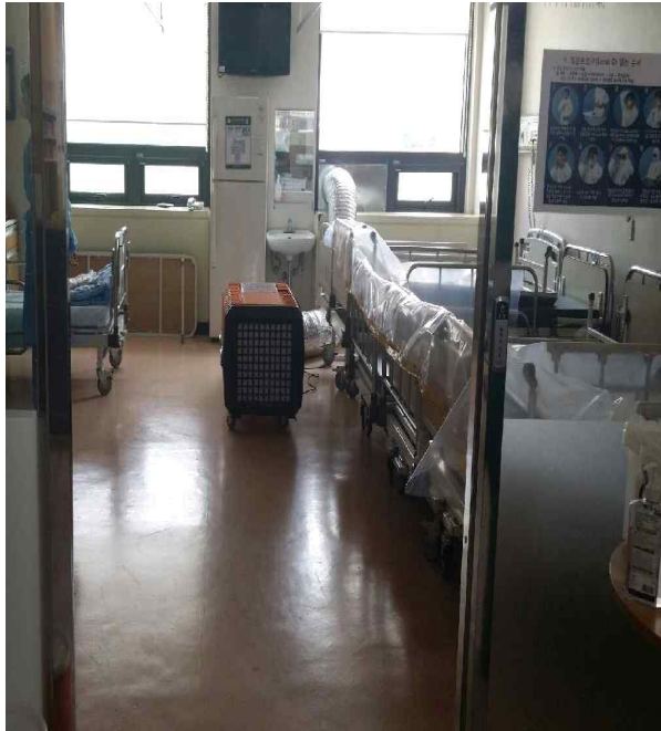
전실 및 음압기 설치
