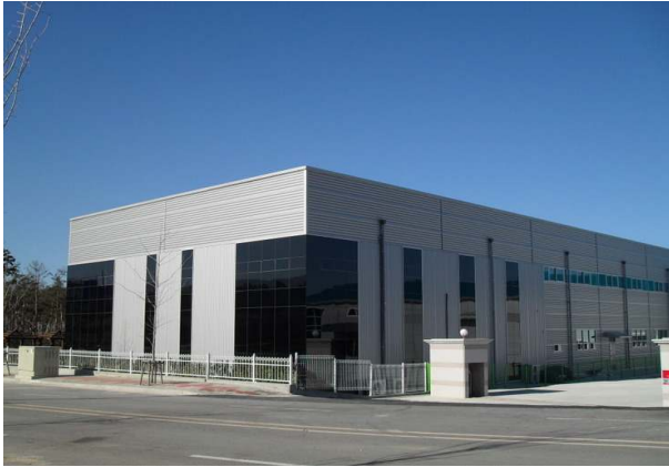
철골조 조립식판넬 마감(사무실, 공장)
