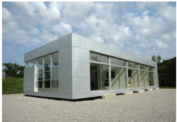
조립식판넬조 이동형 주택
