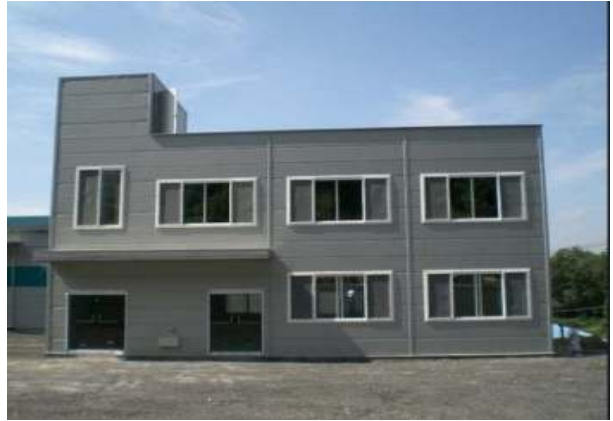
철골조 조립식판넬 마감(사무실)
